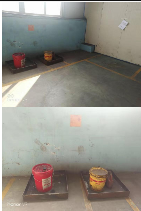
危废暂存间托盘和废油桶
